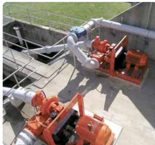
Bombas Dri-Prime con accionamiento eléctrico en instalación permanente impulsando el efluente de un filtro percolador secundario a una cámara de cloración y descarga posterior.
